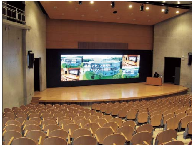
▲600名収容の大講義室に導入されたマルチスクリーンシステム。32台の高輝度ディスプレイで構成し、ステージを最大限に有効活用。明るい室内照明下でも鮮明な映像を表示する。
