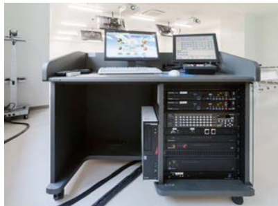
タッチパネルコントローラーを装備し簡単に操作できる映像・音響操作卓
