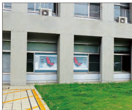
▲一部の窓ガラスにリア透過タイプのフィルムスクリーンを貼り、室内のプロジェクターから映像を投写。学生の作品などを表示するサインージシステムとして活用している。
