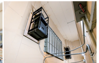
▲ 映像ホールの様子。WS-HM5104とWS-HM518Lが1台ずつスタッキングされ、正面の壁裏に格納されている
