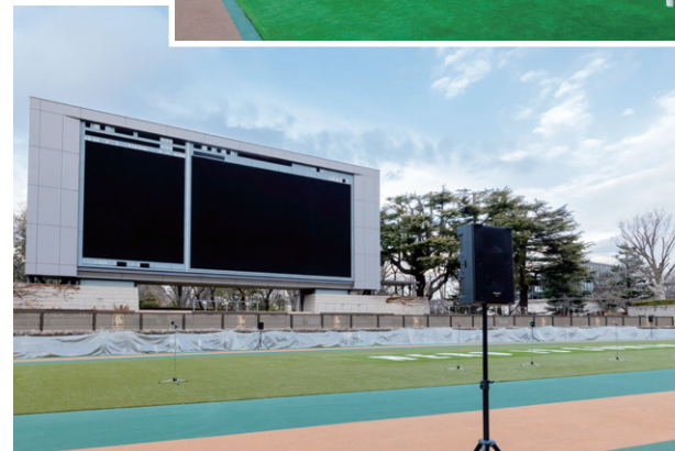
◀ パドックのイベント用放送システム。WS-AR200-K、WS-AR080-Kがそれぞれ4台ずつ、可搬式スピーカーとして導入された
