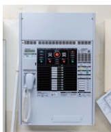
▲馬場内地下道の非常放送システムは壁掛形非常用放送設備 WK-EK310を採用
