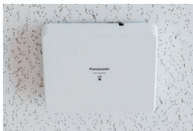
▲ゲストルームの天井に設置されたワイヤレスアンテナWX-SA250A
